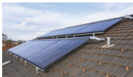
Auch bei diesem Mehrfamilienhaus in Basel setzt man auf Sonnenenergie für das Warmwasser: – Mehrfamilienhaus mit 24 Wohnungen – Gasheizung in Kombination mit thermischer Solaranlage – 24 Quadratmeter Röhrenkollektorfläche – 60 Prozent solarer Deckungsgrad. Planung und Umsetzung: Omlin Energiesysteme AG | Produkte: Viessmann (Schweiz) AG
